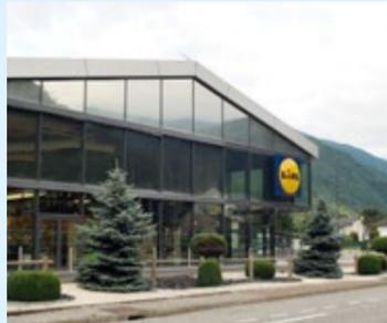
Ce supermarché reprend les règles d'urbanisme régissant la zone, la toiture en deux pentes et comprend une pente forte de toiture en cas de chute de neige. L'extérieur de ce supermarché est en bardage bois, il est constitué de poteaux béton.
